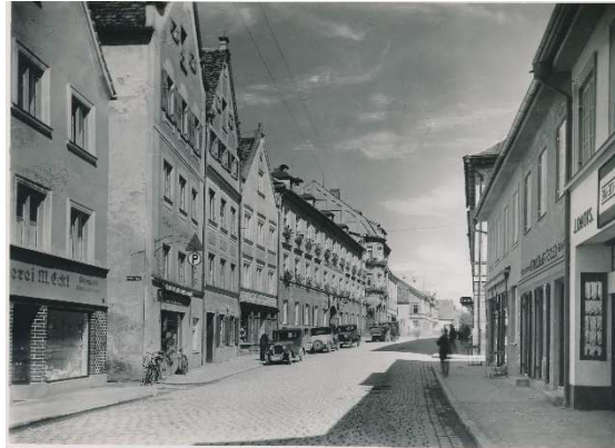
Schmieidstrasse nach Norden (Quelle: Dr. Heberlein)
